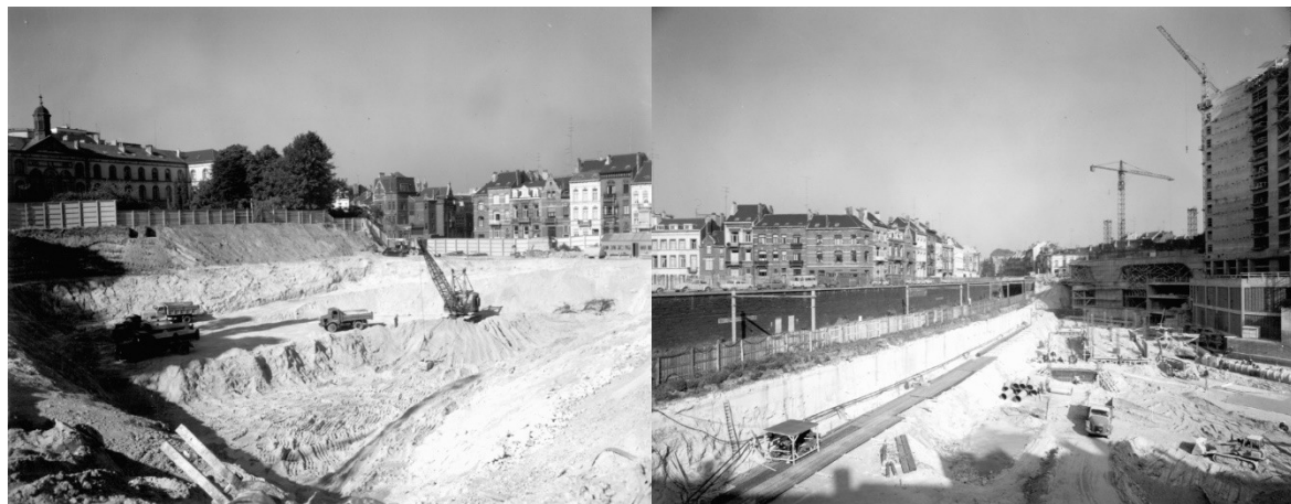
Figure 8 Bd Charlemagne - Rue Joseph II 1962-1965 (Bruciel) - Construction du bâtiment Berlaymont
