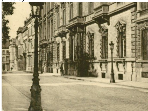
Figure 4 Palais du marquis d'Assche (Bruciel)
